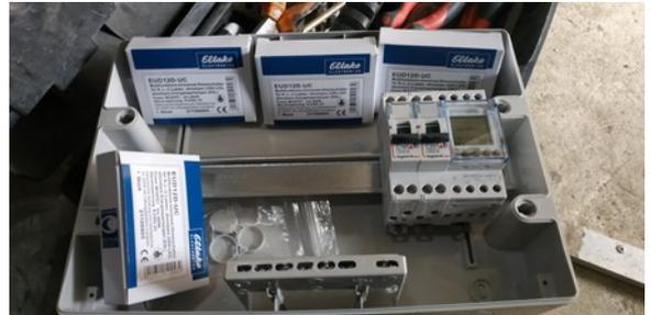
Réalisation de 4 zones d'éclairages pour 11 pigeonniers à extinction crépusculaire grâce au module électronique de variation multi-fonction et programmateur hebdomadaire
