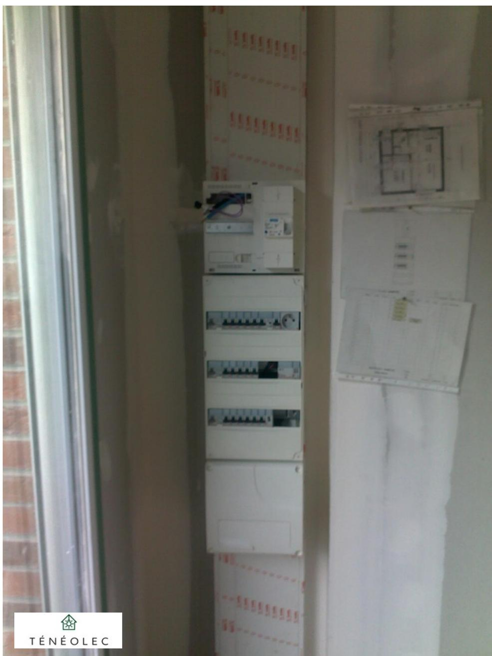
Pose d'un tableau de distribution pour un étage avec 4 pièces et une salle de bain et tirage des câbles.
